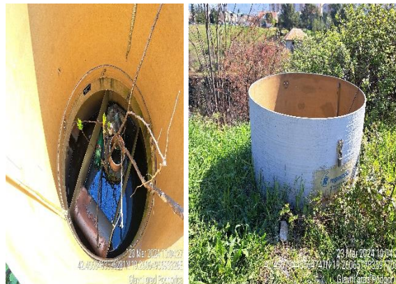
Naziv slike/oznaka na mapi: M6 Tip zagađenja: Neadekvatno održavanje separatora duž magistralnog puta Podgorica-Danilovgrad - Moguće hemijsko zagađenje vodotoka Ocjena opasnosti: Umjeren nivo opasnosti
